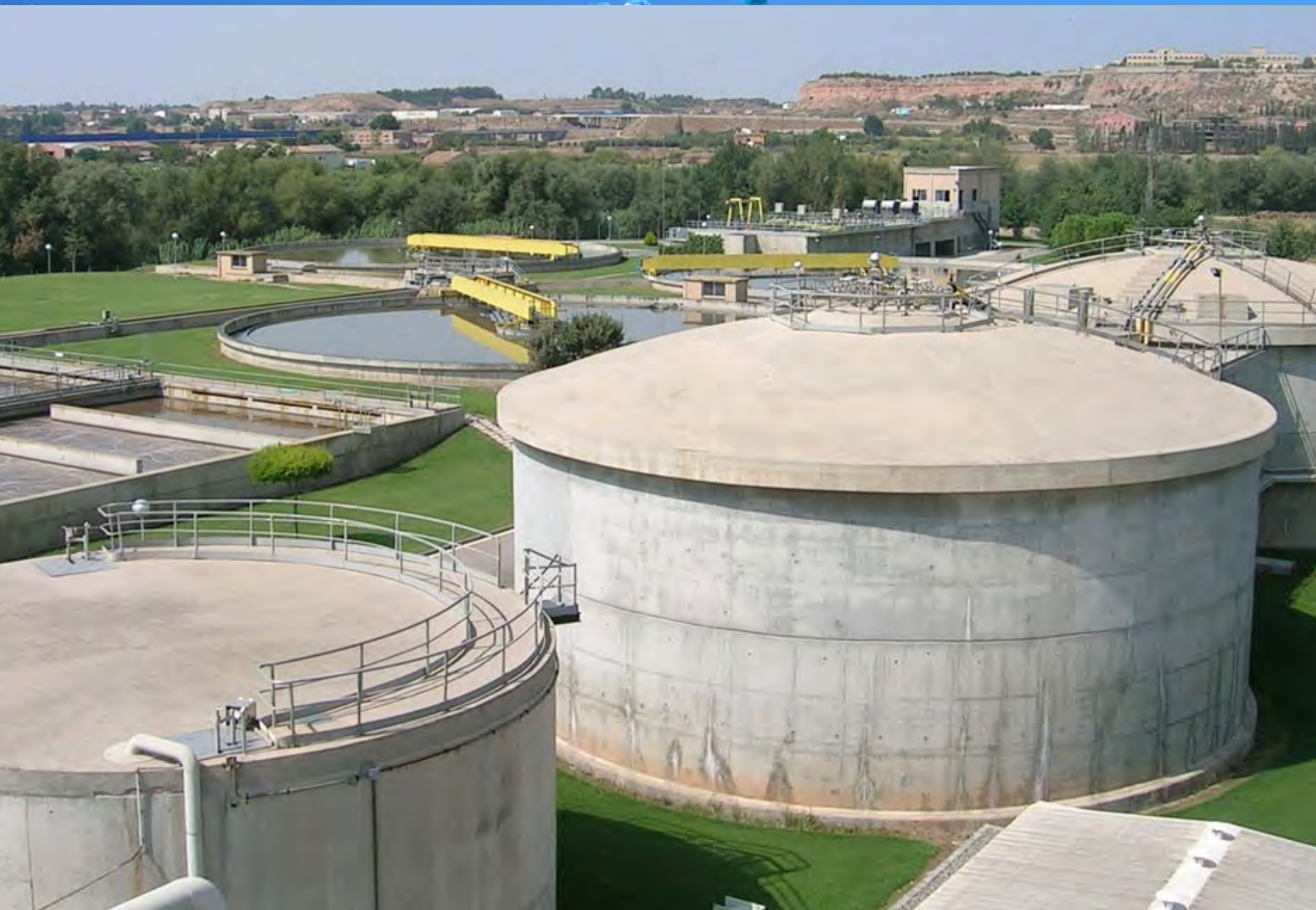
Lleida Wastewater Treatment Plant (Catalonia).
